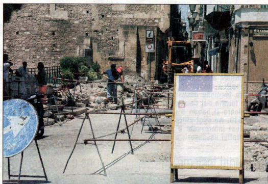
Il cantiere che si è aperto in via Duomo
